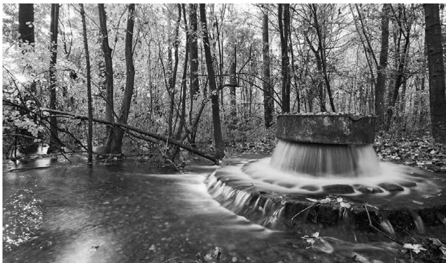
Wasseraufbereitung in den Langen Erlen
